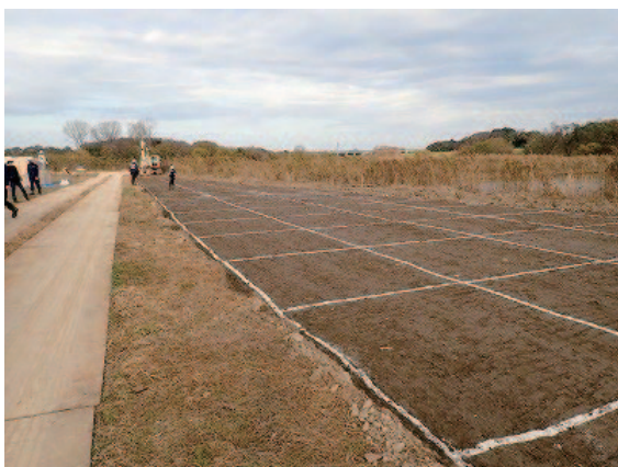
写真1 改良前の状況
