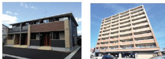
写真2 九州地方での登録物件の典型例 出所：セーフティネット住宅情報提供システムサイトより
