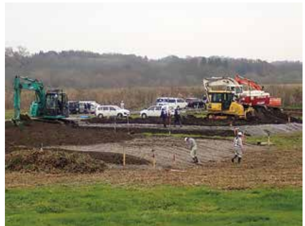
利根川遊水地での現場実証実験
