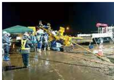
写真1：液状化対策施工の確認状況
