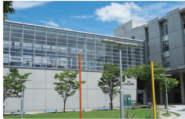
外観[第18回福岡市都市景観賞受賞]
